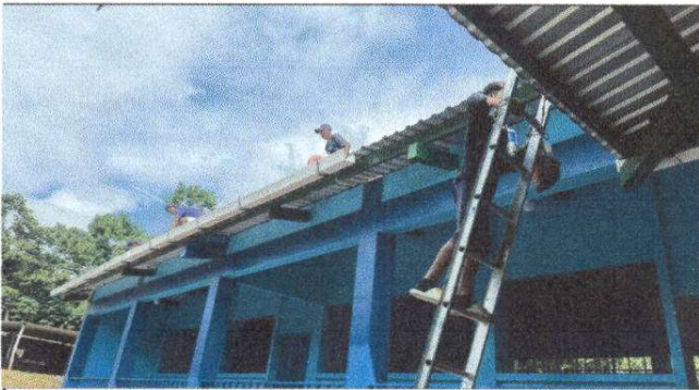
Fotografía 3. Canales y bajadas de agua pluvial
