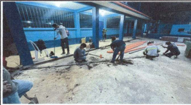
Fotografía 7. Red de agua potable, sustitución de tubería línea principal.
