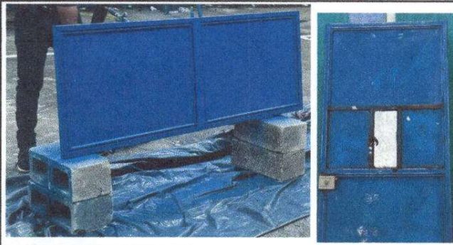
Fotografía 1. Mantenimiento a estructura de puertas de metal.
