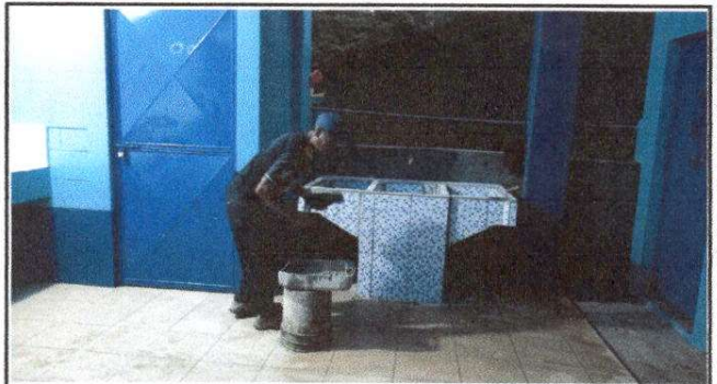
Fotografía 10. Intalación de pila de dos lavaderos.
