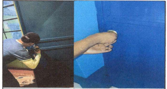
Fotografía 2. Sustitución de chapas de puertas de metal
