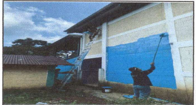
Fotografía 4. Pintura en muros interiores y exteriores.
