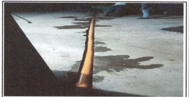
Fotografía 6. Sustitución de tubería PVC línea principal aguas negras.
