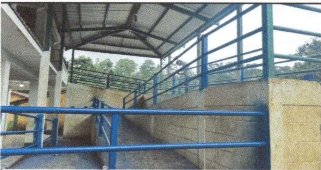
Fotografía 5. Mantenimiento a barandas.
